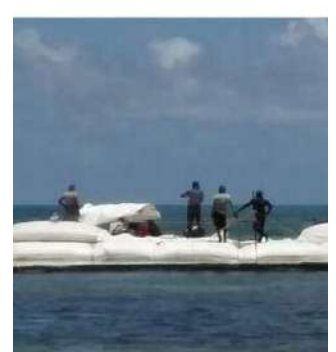
Arrecife de Concreto
